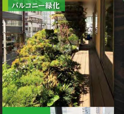
ビルの高層階でも 人が管理できる 通路の外側に植栽 基盤を配置しつつ、 外側から壁面緑化 がみせられる工法 です。
